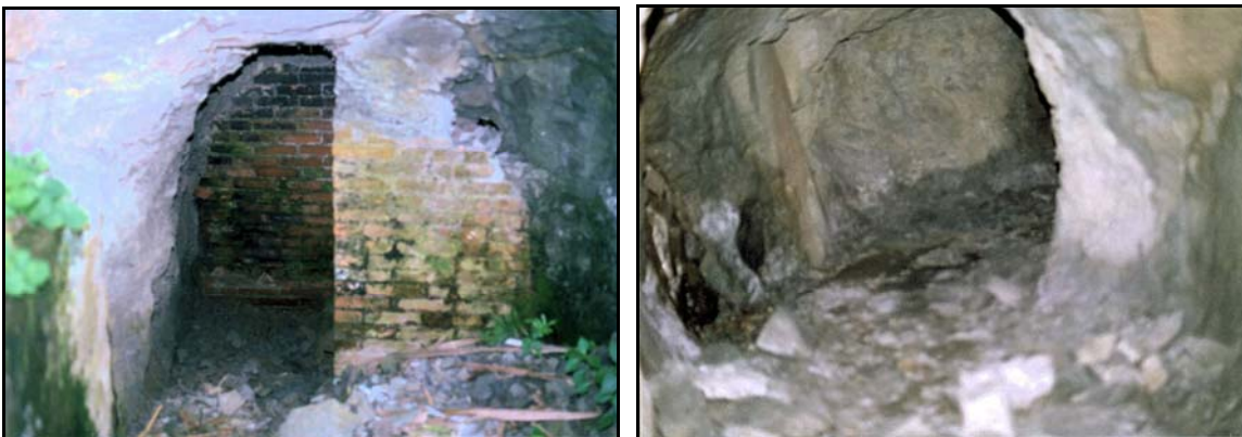
(左)基隆大沙灣的防空洞，洞口用二道厚磚牆，遮蔽半洞，做為屏障牆，以防止洞口被轟炸而炸彈破片直射入內。(右)洞內是沙質岩，容易挖掘。
