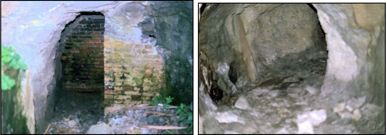
圖 10 基隆大沙灣的防空洞，洞口用二道厚磚牆，遮蔽半洞，做為屏障牆，以防止洞口被轟炸而炸彈破片直射入內(左)。圖 11 洞內是沙質岩，容易挖掘(右)。
