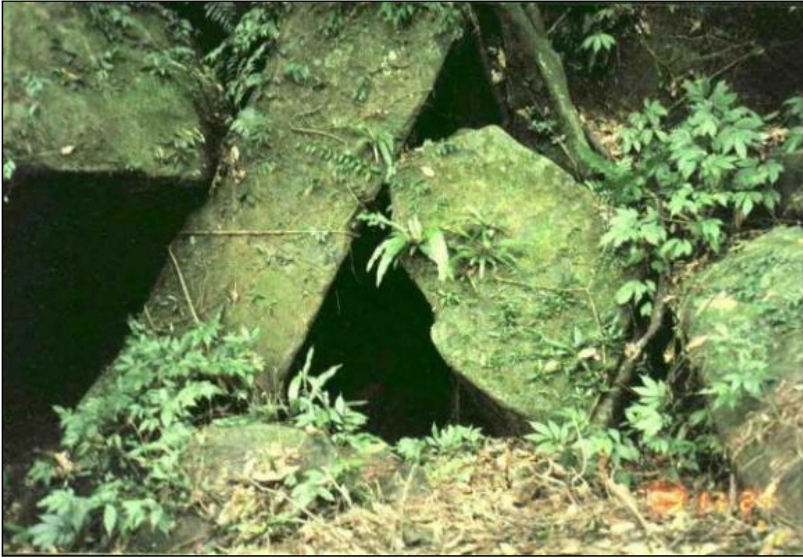
七星堆附近地洞洞口已崩塌
