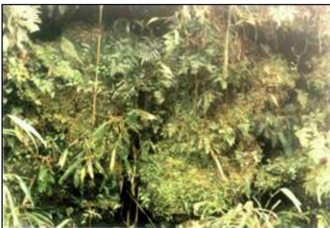
金字塔砌石本體覆蓋物清理前
