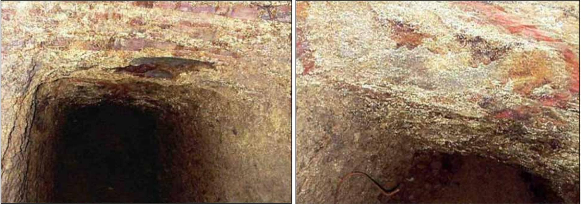
第一、二號地洞在洞內壁上，滿佈金光閃閃、歷久彌新的金屬質素。這些金屬質素是在冶煉金屬時，煙含金屬質素附著於洞壁的。
