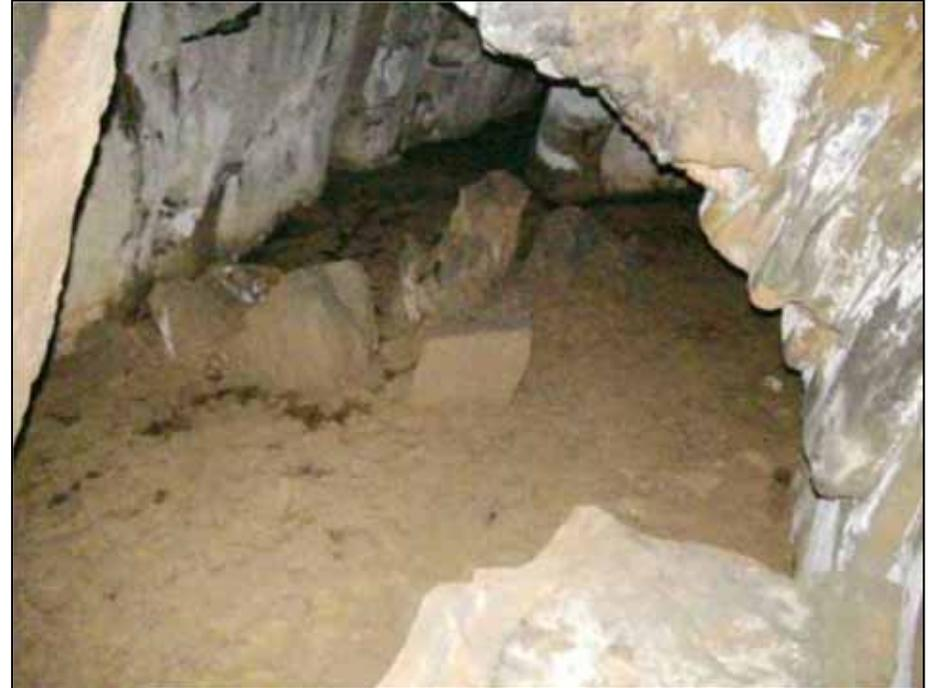
濂洞國小地洞長約百餘公尺，左圖入口處呈漏斗型，可收集北風吹入地洞，增加空氣流通。右圖洞壁均為堅硬岩質，避開軟弱地層，顯示古代人工建構物。
