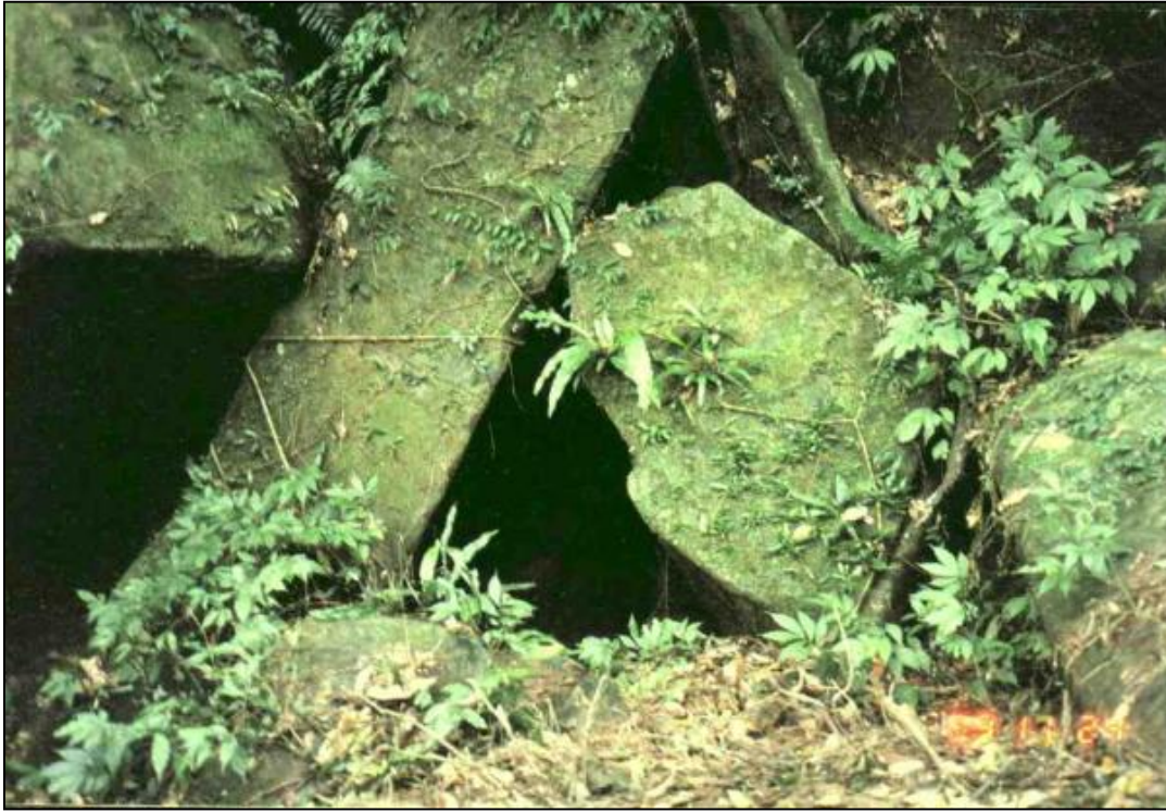
七星堆附近地洞洞口已崩塌
