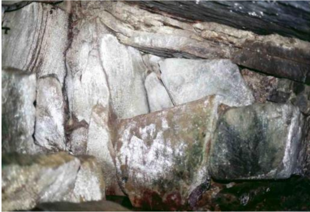
新北市福隆七星堆附近地洞，內壁地層破碎帶，以大石塊支撐。
